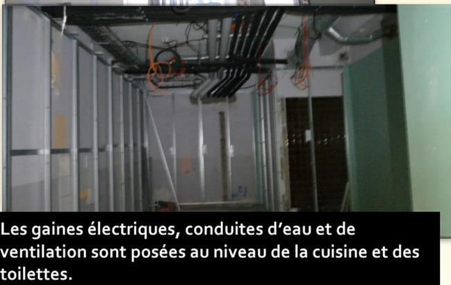
Les gaines électriques, conduites d'eau et de ventilation sont posées au niveau de la cuisine et des toilettes.
