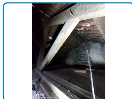
Maison principale 2ème étage Combles
