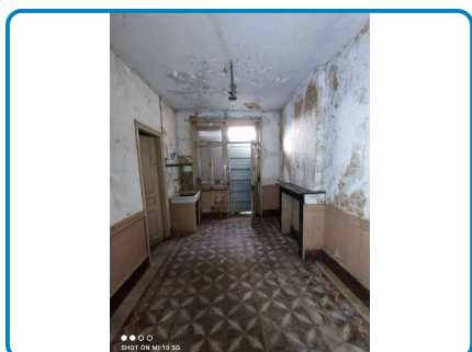
Maison principale Rez de chaussée Cuisine
